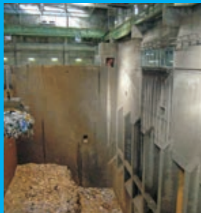
ごみピット内
